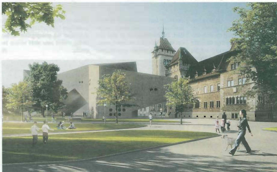
Blick vom Platzspitz: Alt- und Neubau verschmelzen zu einem harmonischen Ganzen; (c) Architron
